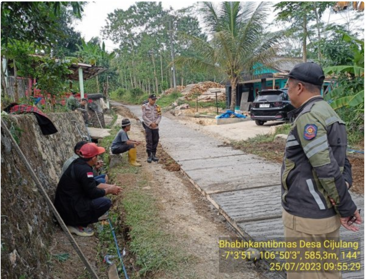
Aipda Sudiro Monitoring Pembangunan MCK di Desa
