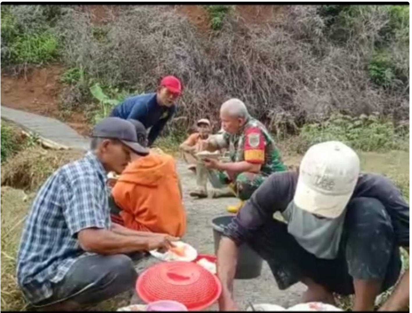
Babinsa Desa Pangkalan, Peltu Dasik Darmawan Monitoring Infrastruktur di Desa Binaanya
