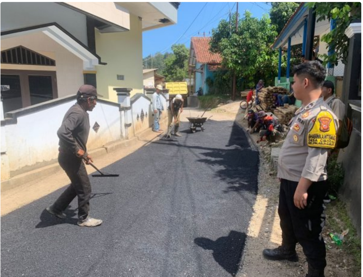
Bripda Erwin Bhabinkamtibmas Polsek Palabuhanratu Polres Sukabumi Monitoring Pembangunan Jalan di Desa Binaannya
