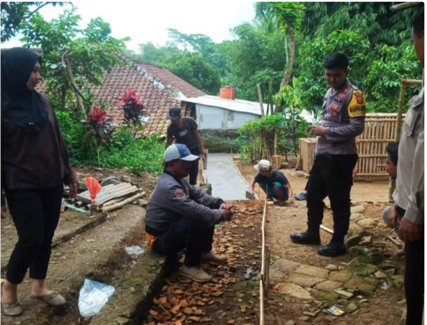
Bripda M. Reza Rizaldi Ajak Warga Kp. Pareang Gotong Royong dalam Rehabilitasi Jalan Lingkungan
