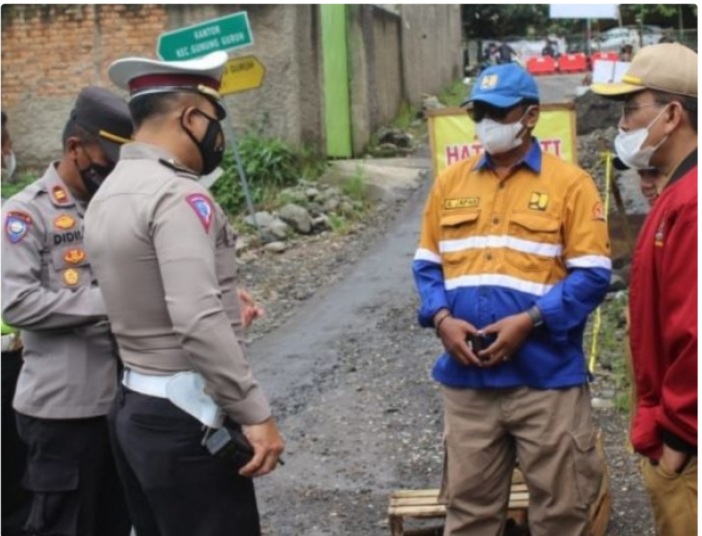
Jalan Rusak di Desa Cikujang Akibat Bencana Alam, Kadis PU Kabupaten Sukabumi: Akan Segera Diperbaiki
