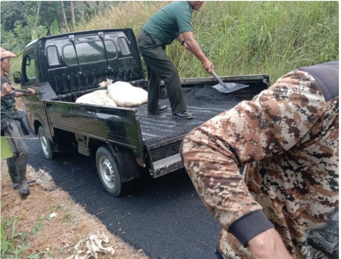
Koramil 0622-04/Cikidang Monitor Pembangunan Jalan ADD Sepanjang 400 M
