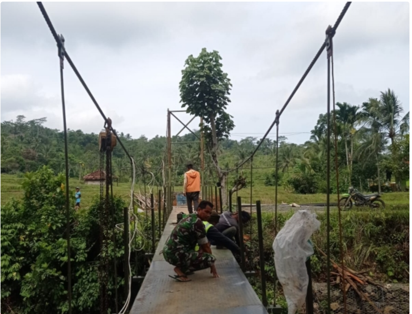
Kpt Arm Witono: Pengerjaan Jembatan Gantung Sudah 80%
