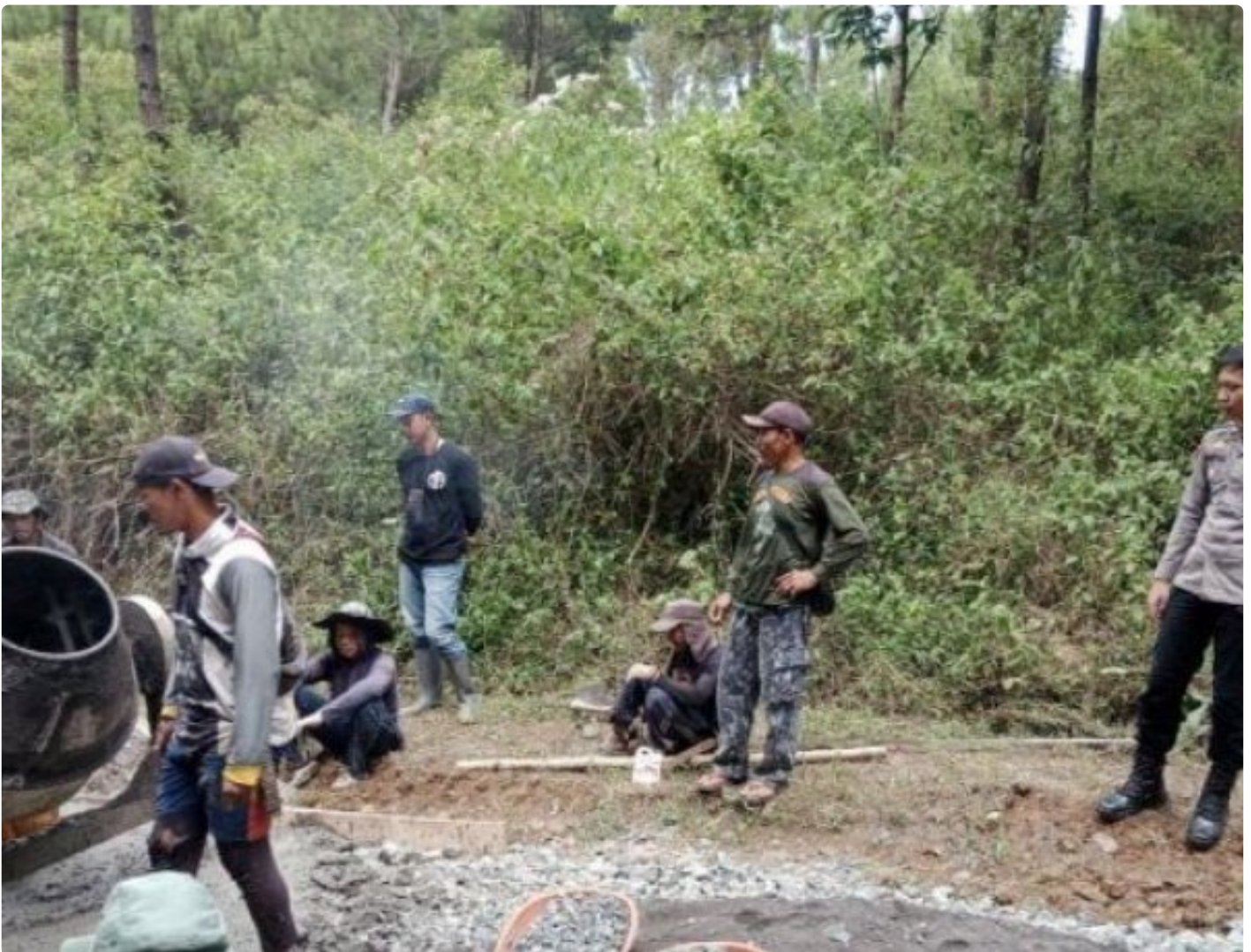
Polsek Jampang Tengah Polres Sukabumi Monitoring Pembangunan Jalan Desa
